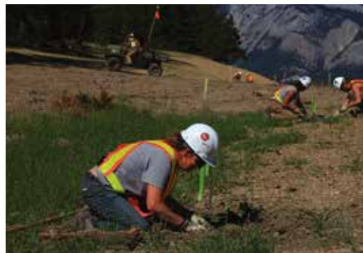
Arpentage de l'emprise en préparation des travaux de construction.
